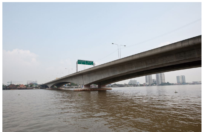
タイ・ラマ5世橋開通（ワットナコンイン橋及び付帯道路建設事業）〈有償資金協力〉 2002年6月
