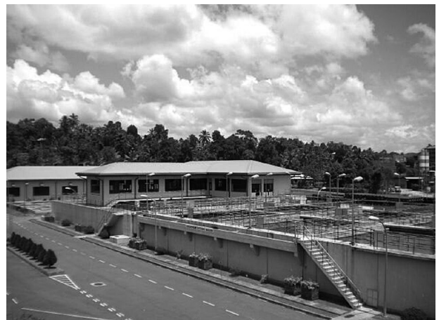
特別円借款（キャンディ上水道整備事業、2001年）により整備されたスリランカ・カツガスタ浄水場
