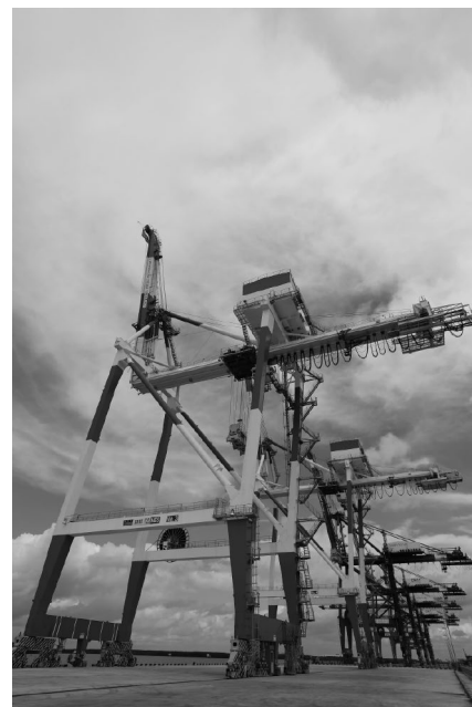
ベトナム「カイメップ・チーバイ国際港開発事業」(2005年)により設置されたコンテナクレーン
