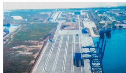
ルーマニア・コンスタンツァ南港整備事業竣工 〈有償資金協力〉 2003年11月
