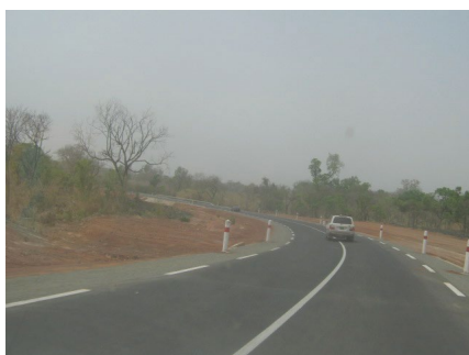
アフリカの民間セクター開発のための共同イニシアティブ（EPSA）第一号案件（バマコーダカール間南回廊道路改良・交通促進事業）の円借款貸付契約を締結 2006年3月 完成後の道路
