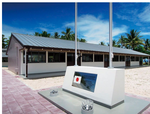
無償資金協力により建設されたツバルの公立高等教育学校の教室棟（モトフォウア高等教育施設整備計画） 2011年8月
