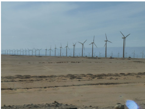
ODA事業として世界初のクリーン開発メカニズム事業に認定されたエジプト・ザファラーナ風力発電所 2007年6月
