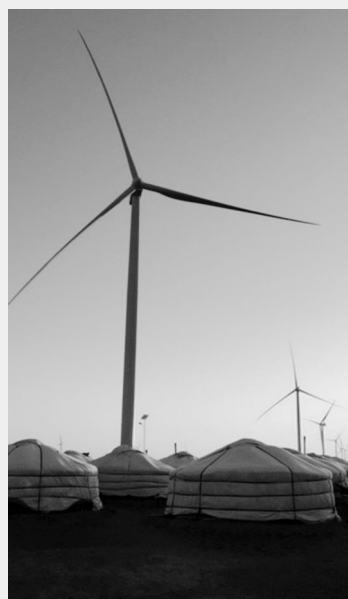
モンゴルのツェツィー風力発電所
